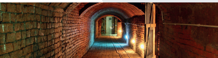
© Chemnitzer Gewölbegänge e.V.
